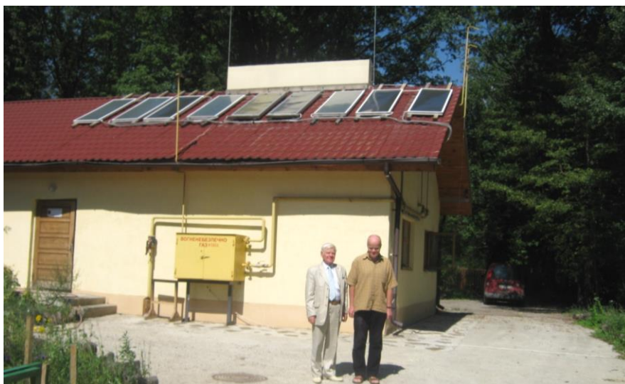
Р и с. 3. Солнечная установка детского дома. Общая площадь 13,5 м 2 . Производительность 1000 л в день
