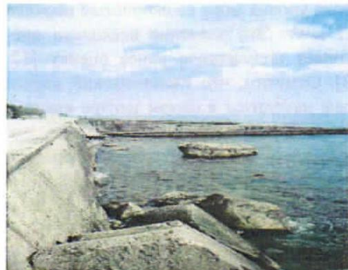
Рис. 7. Полуразрушенные бунные сооружения в районе Кацивели
