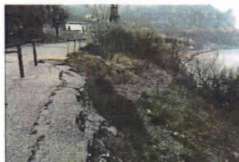
Рис. 6. Оползень берегового обрыва с обрушением дороги в центральной части Лименской бухты, активизировавшийся в результате отбора гальки на строительные нужды в 1960–70-е годы
